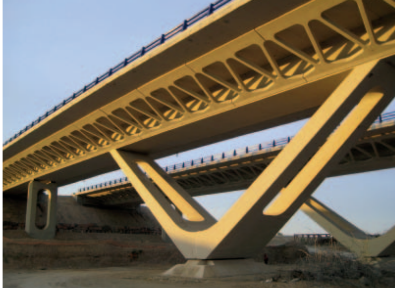
FOTO 2 Pont prefabricat continu de formigó pretesat de la ronda de Saragossa.
