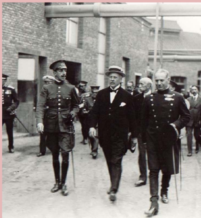
VISITA PRINCIPAL A LA FÀBRICA DEL PRIMER PROPIETARI
