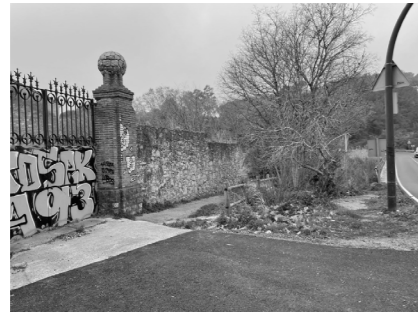
Estado actual - conexión Pont Vell
